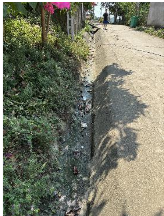
Mương hở (thoát rãnh)
