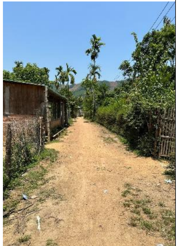
Đường dây hạ áp
