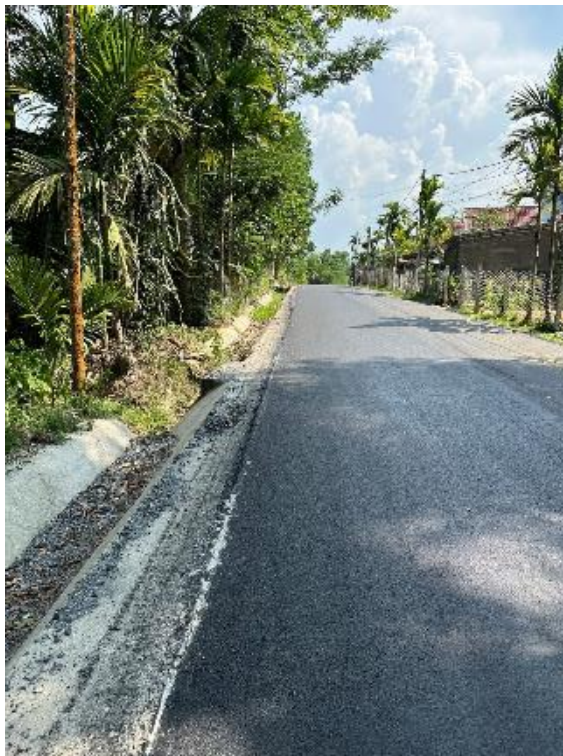
Mương hở (thoát rãnh)
