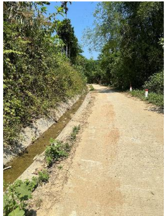
Mương hở (thoát rãnh)
